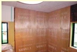
内壁の耐震補強
