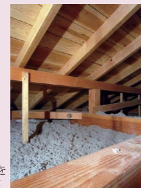
セルローズファイバーを吹き積もらせた天井裏
