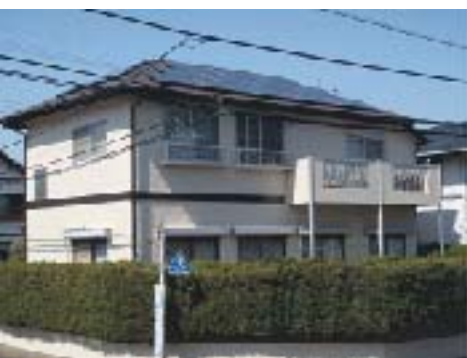
屋根に設置された太陽光発電パネル
