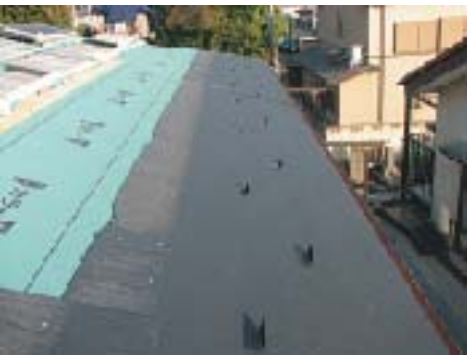
屋根葺替工事
