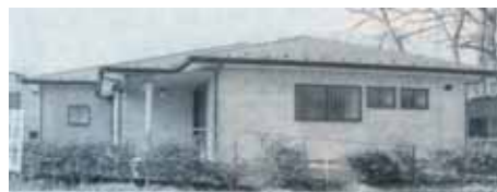
▲2003年3月竣工桶川市殿山団地自治会館
