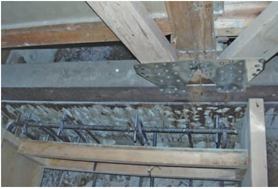
▲A邸耐震補強工事
