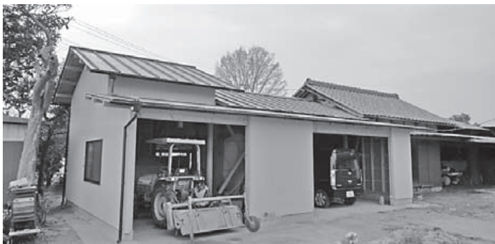
▲倉庫改修工事
