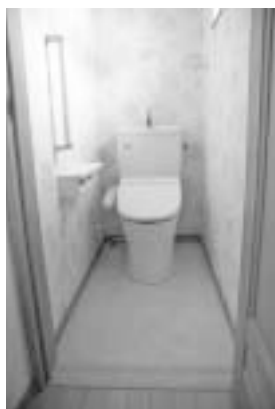
トイレ改修工事
