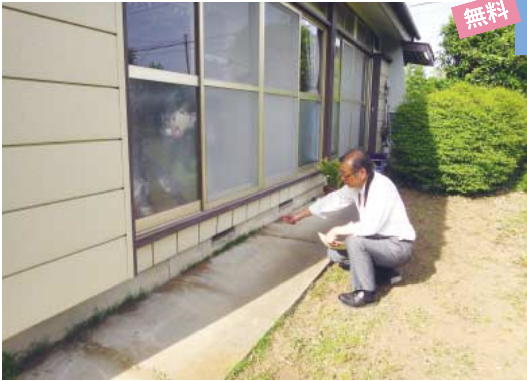
▲基礎の目視点検
