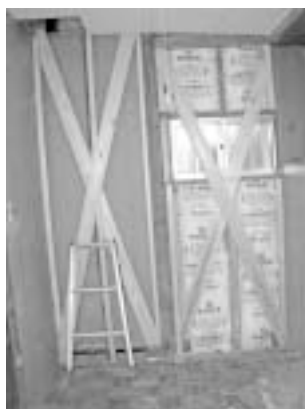
壁耐震補強工事
