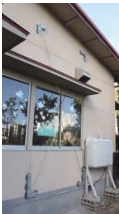
外部から窓面に取付けた鋼製の筋かい
